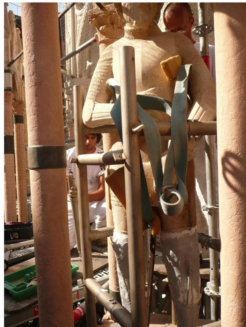
E' stato condotto un progetto sperimentale non invasivo basato su indagini radiografiche e pacometriche atte a dimensionare l'armatura lenta inserita all'interno delle gambe che ha permesso un intervento mirato di risanamento e restauro del bene.
